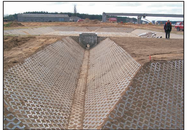
Droga S5 - budowa zbiornika odprowadzającego.
