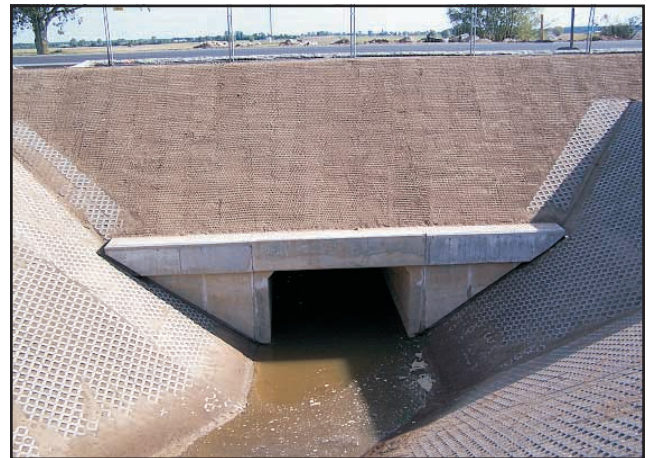
Droga S5 - budowa przepustów.
