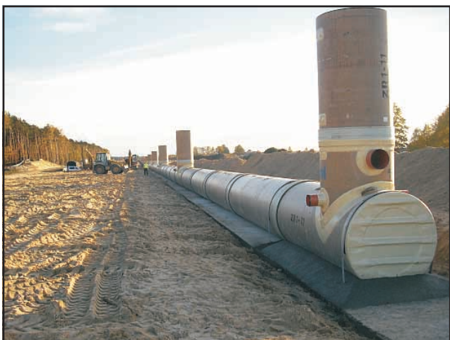
Budowa kanalizacji deszczowej wraz ze zbiornikami podziemnymi z rur GRP na drodze ekspresowej S8.
