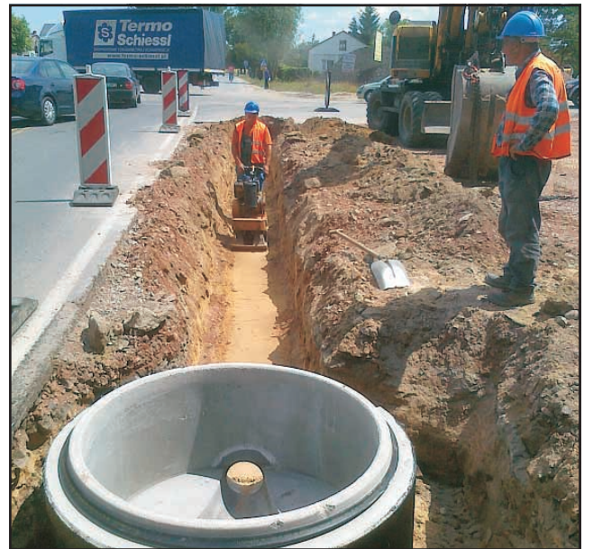
Droga nr 703 - budowa kanalizacji.
