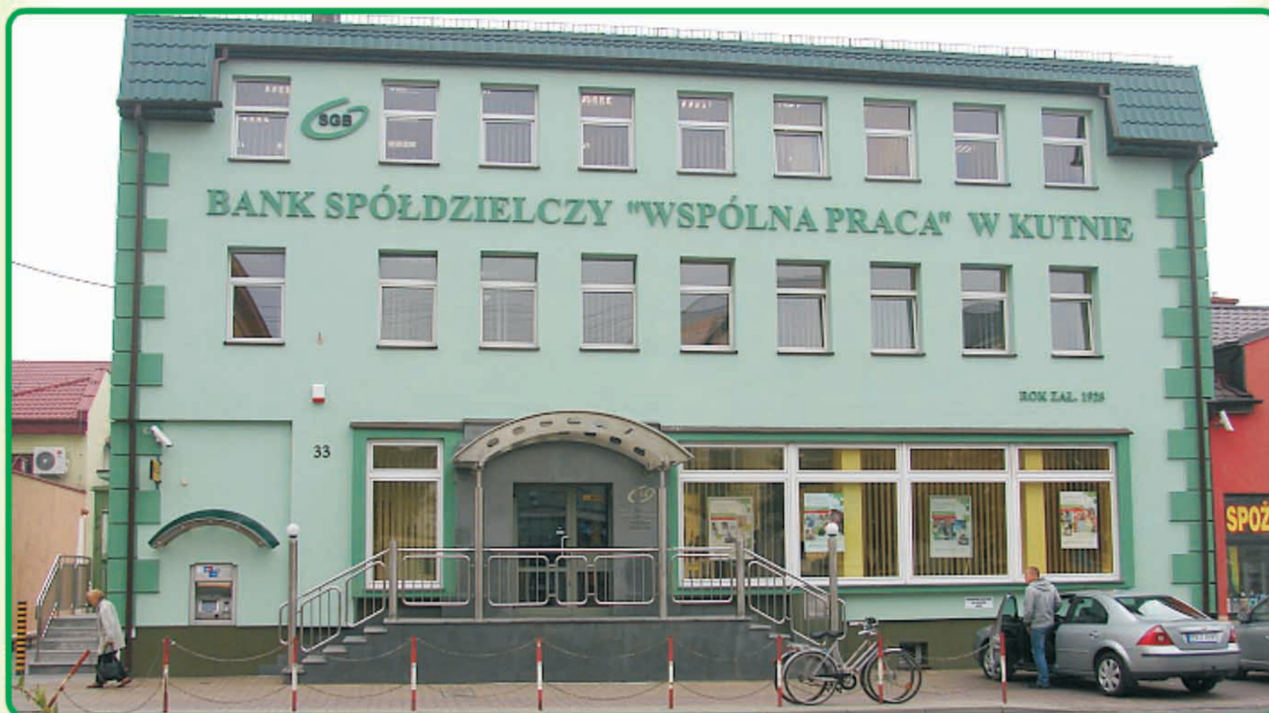
Bank Spółdzielczy "Wspólna Praca" w Kutnie po modernizacji (z dobudowanym piętnem i nową elewacją).
